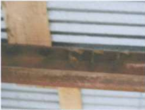
Նկ. 4. Չեղմահարվի կարկասի ժանգապառ տարրերի տեսքը
